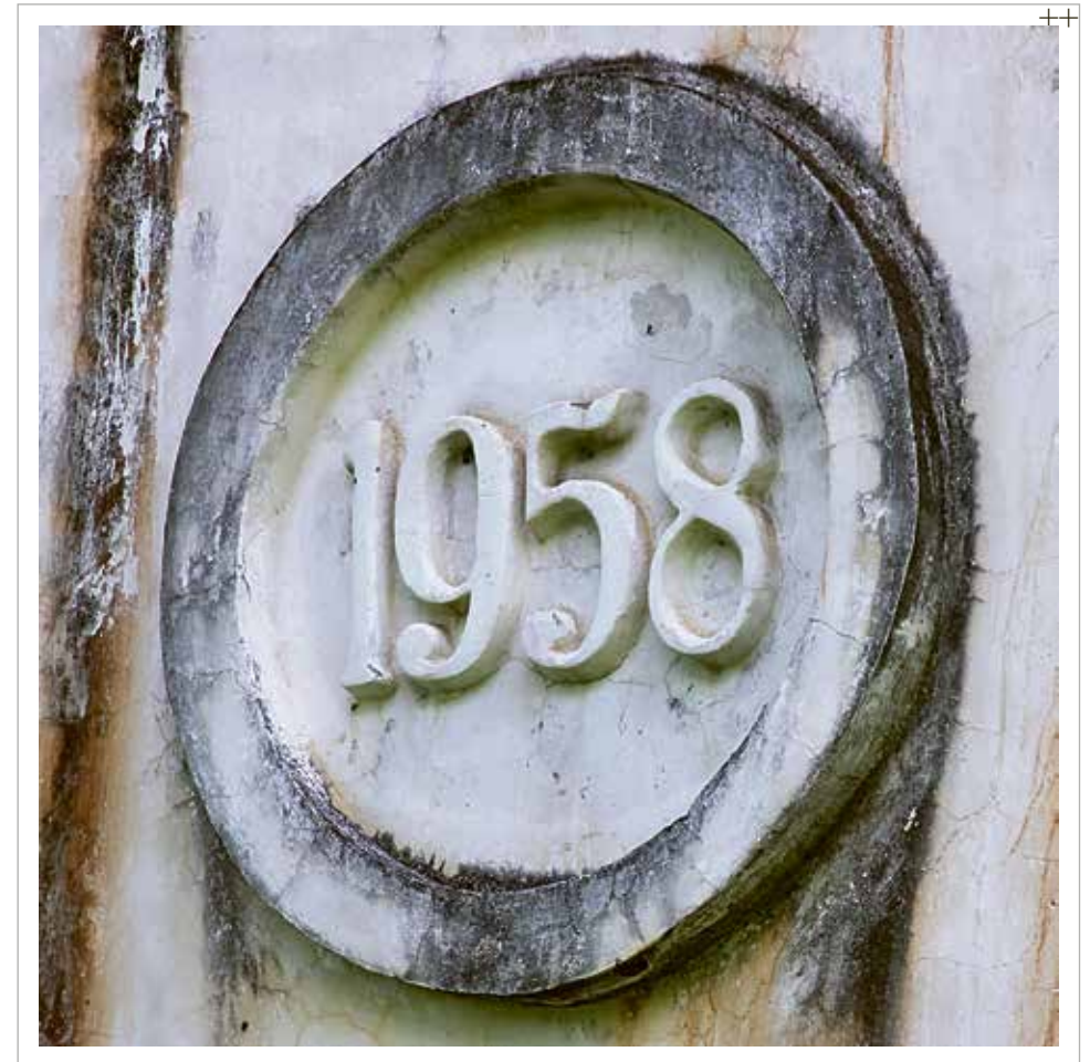
29 (28). Надпись: «В.-Рубахинская ГЭС, 1958 год» над парадным входом в каменное здание, в стенах которого были расположены турбины и генераторы ГЭС. Фото 2020 г.
