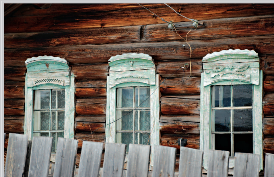
52 (18). «Очелья» (верхние части оконных наличников) с элементами накладной резьбы. Село Подволочное Усть-Удинского района Иркутской области. Фото 1997 г.
