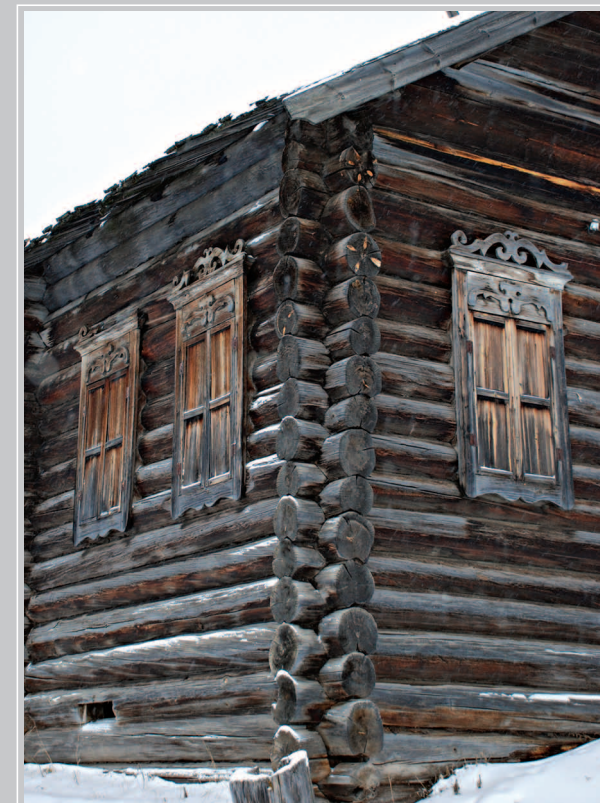
49 (18). Дом-пятистенок, рубленный в «угол» (с выпуском торцов). Село Иркинѐево Богучанского района Красноярского края. Фото 1991 г.
