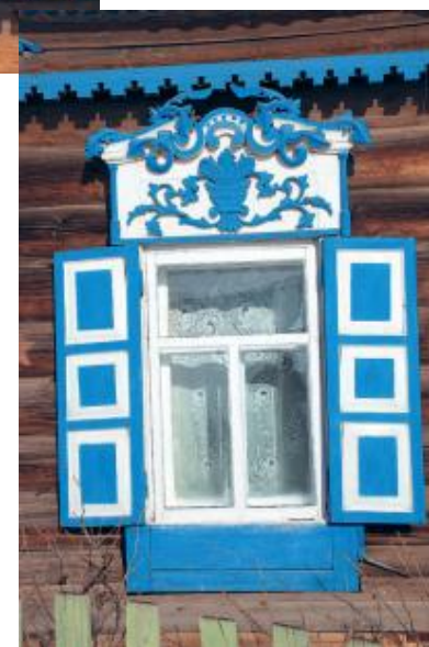
Накладная резьба на наличниках окон и на верхней части дома. Посёлок Верхнемарково Усть-Кутского района Иркутской области. Фото 2011 г.
