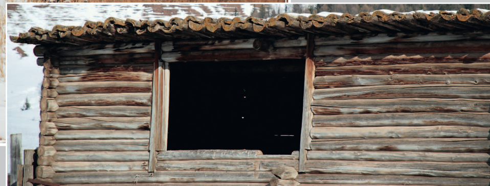
846. Фрагмент верхней части повёти с желобковой крышей. Фото 1991 г.
