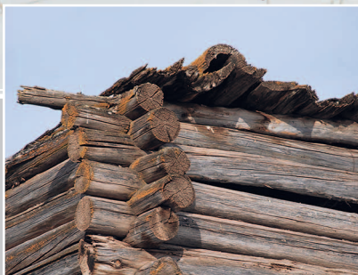
844. Четырёхкамерная повётъ под желобковой крышей — помещение, используемое для хранения сена, соломы (верхняя часть) и содержания домашнего скота (нижняя часть). Село Заплёскино Жигаловского района Иркутской области. Фото 1998 г.
