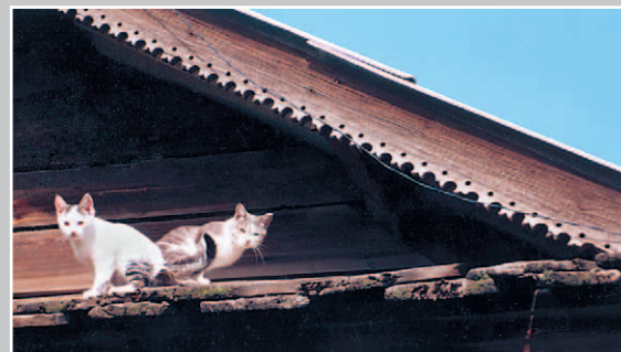
734. Резная причёлина крыши дома. Село Нижние Ключи Нерчинского района Читинской области. Фото 1985 г.
