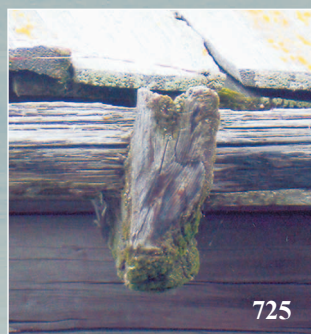
724-725. Кокора (курица) — стропильный крюк, сделанный из корневища дерева. Село Хор-Тагна́ Заларинского района Иркутской области. Фото 1989 г.
