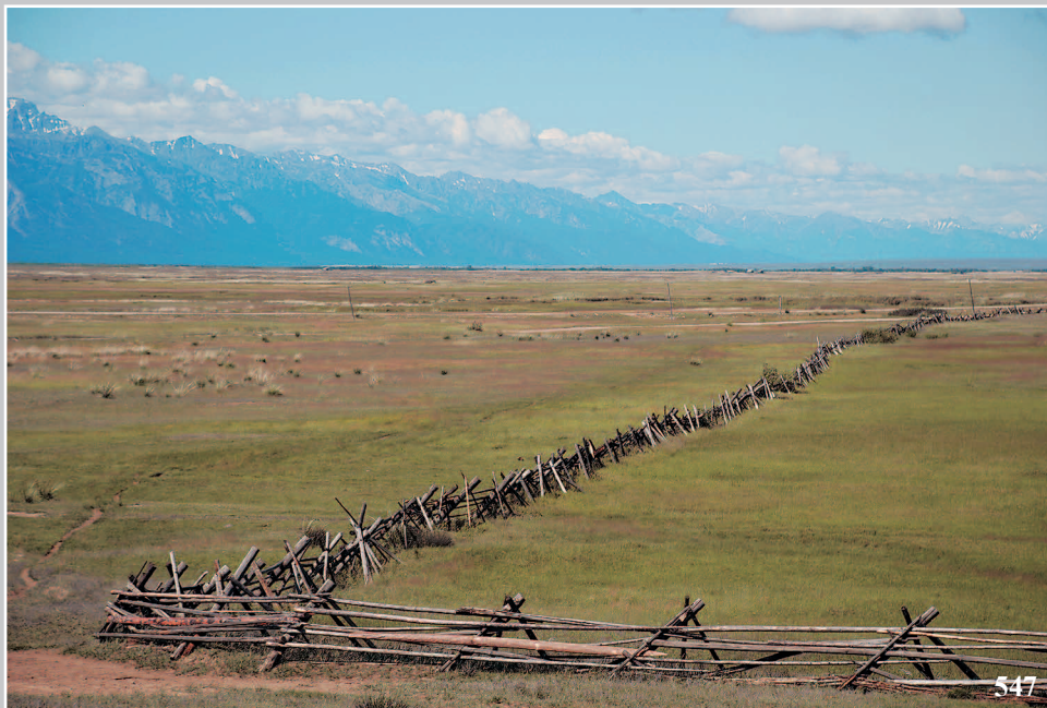
547. Изгородь на «кобылинах» — изгородь из жердей, вставленных в столбы, лежащие на каменистой поверхности. Село Бодён Баргузинского района Республики Бурятия. Фото 1986 г.
