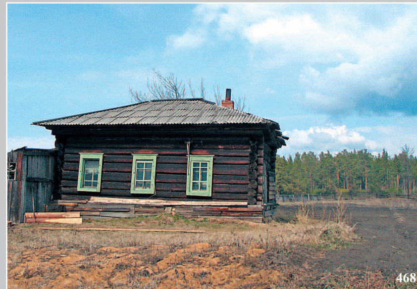
468. Сохранившаяся нижняя часть Никольской церкви в селе Миронька Чунского района Иркутской области. Фото 1997 г.
