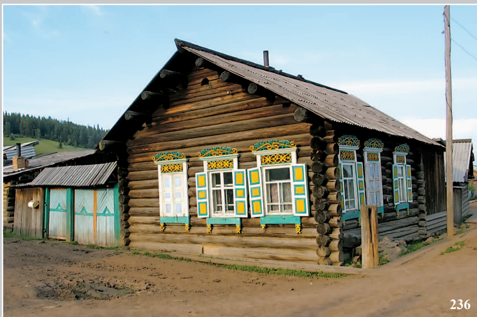
236. Дом с самцовой крышей. Село Ёрба Кежемского района Красноярского края. Фото 1993 г.
