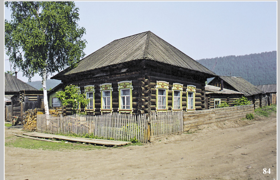
84. Дом-пятистенок в селе Паново Кежемского района Красноярского края. Фото 1997 г.
