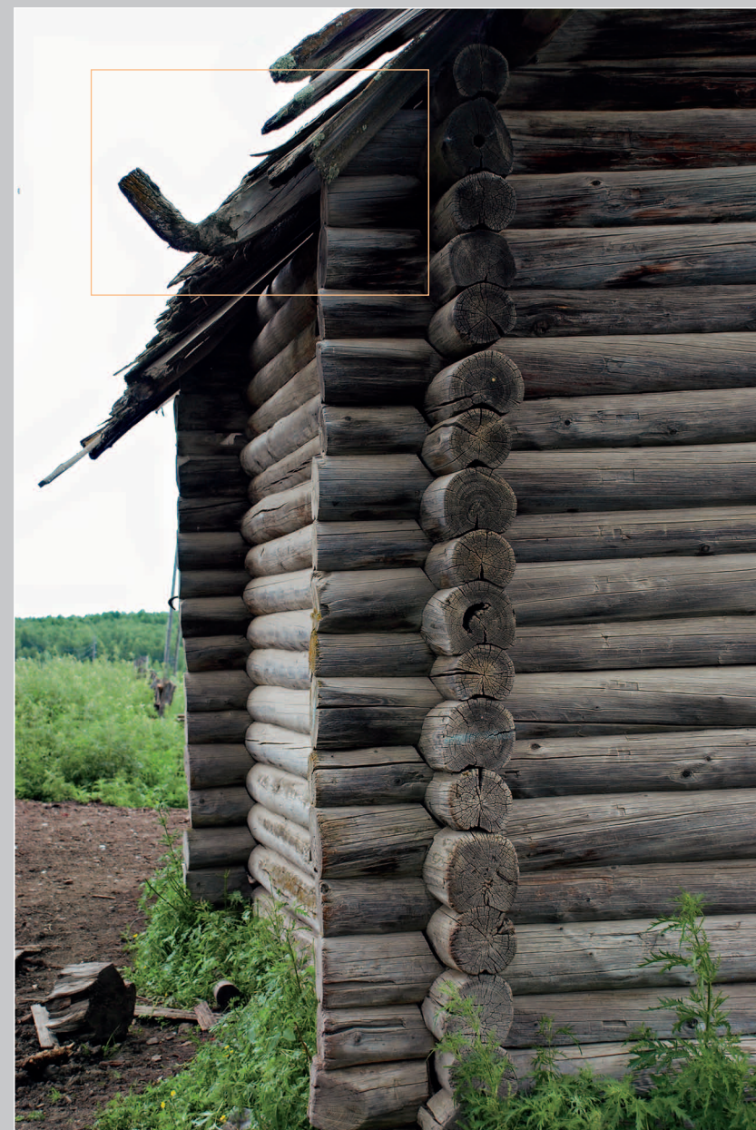
81 (15). Кокора (курица) — стропильный крюк, сделанный из корневища дерева. Деревня Солонцы Газимуро-Заводского района Читинской области. Фото 1999 г.
