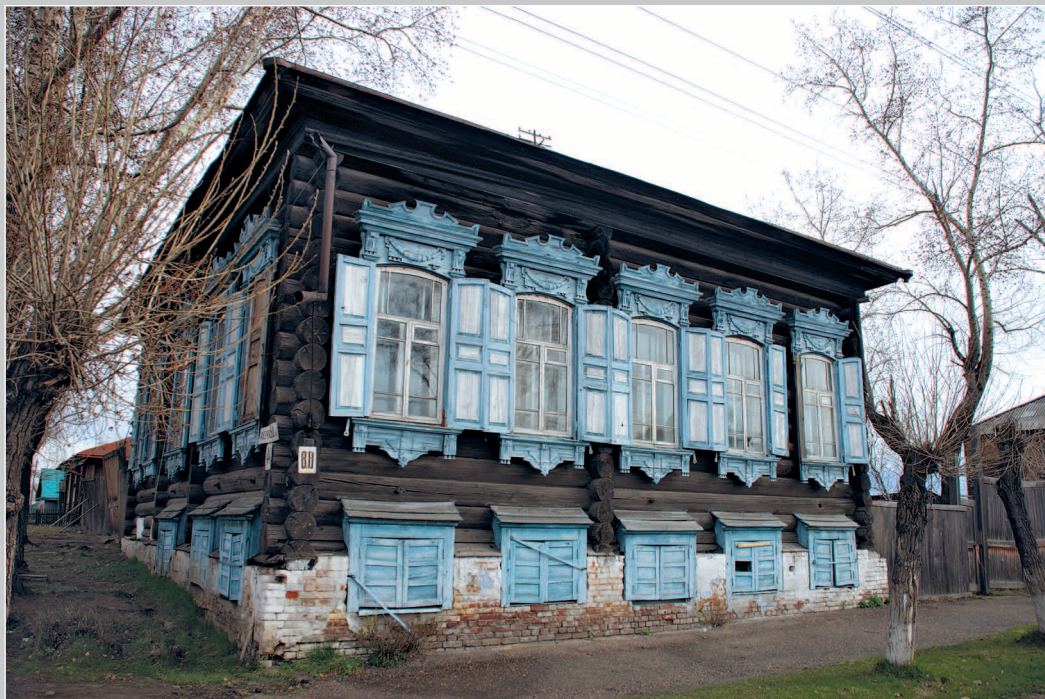
91–92 (10). Дома с подклéтью (нежилым помещением под избой). Город Енисейск Енисейского района Красноярского края. Фото 1998 г.
