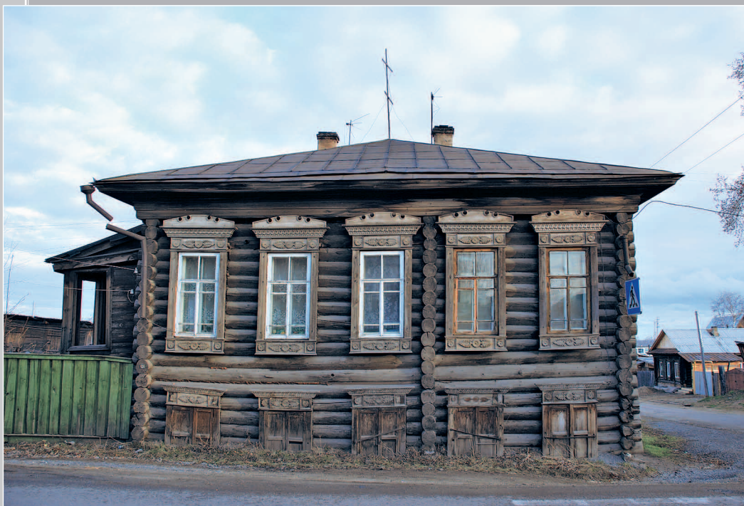
93 (10). Окно, украшенное накладной и пропиленной резьбой. Город Енисейск Енисейского района Красноярского края. Фото 1998 г.
