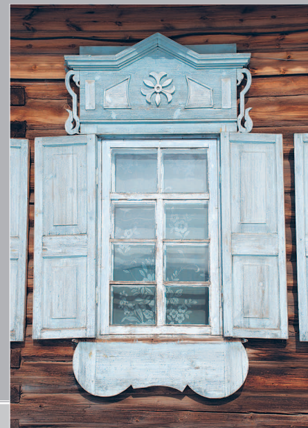
58–59 (10). Накладная резьба на наличнике окна. Посёлок Верхнемарково Усть-Кутского района Иркутской области. Фото 2004 г.
