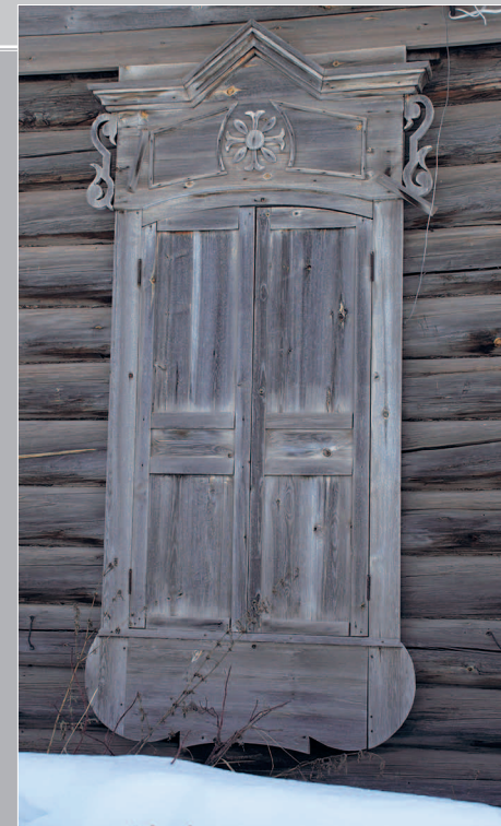
73–74 (10). Село Марково Усть-Кутского района Иркутской области. Фото 2001 г.
