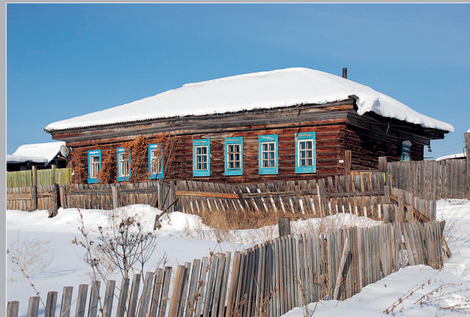
53 (10). Дом-пятистенок в посёлке Верхнемарково Усть-Кутского района Иркутской области. Фото 2010 г.
