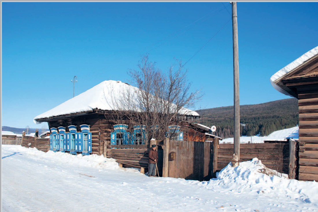
65 (10). Дом-пятистенок с четырёхскатной крышей. Деревня Казарки Усть-Кутского района Иркутской области. Фото 2011 г.
