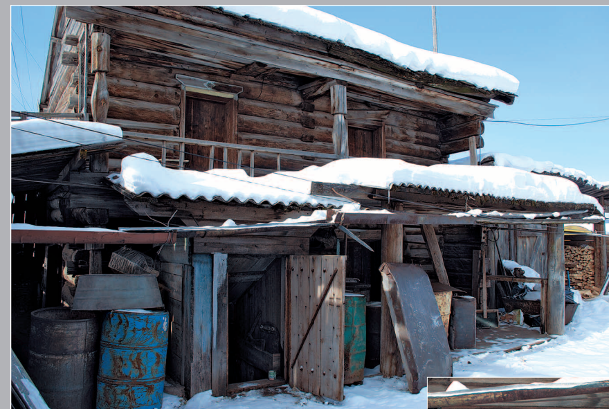
23–26 (10). Двухэтажный амбар с подвалом и ледником — ямой для хранения мяса, рыбы и других продуктов. Посёлок Верхнемарково Усть-Кутского района Иркутской области. Фото 1987 г.
