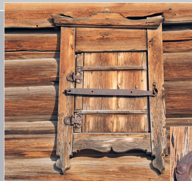
16–18 (10). Окно двухэтажного амбара с «одноставешникóм». Посёлок Верхнемарково Усть-Кутского района Иркутской области. Фото 2012 г.
