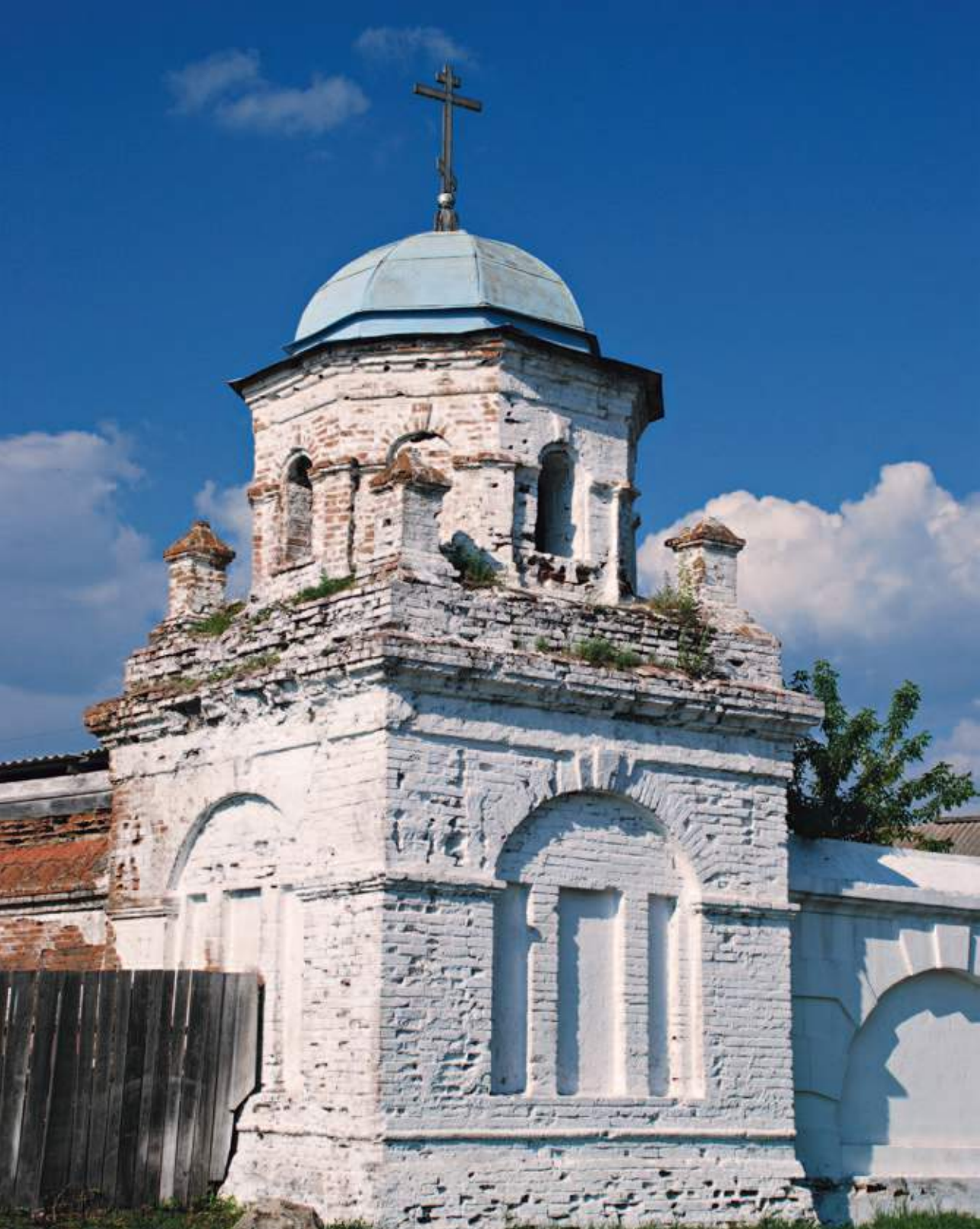
33 (20). Угловая башня Свято-Троицкого Селенгинского мужского монастыря — первого в Забайкалье монастыря, основанного в 1681 г. Село Троицкое Прибайкальского района Республики Бурятия. Фото 2013 г.
